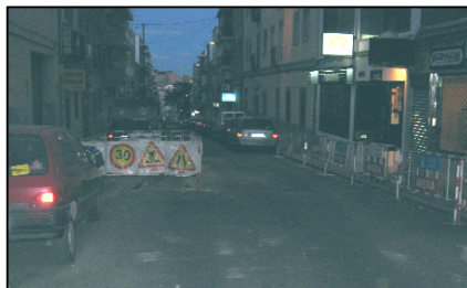
Señalización de obra, señales NO Reflectantes
