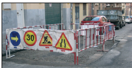
Vallado y señalización de zona de trabajo
